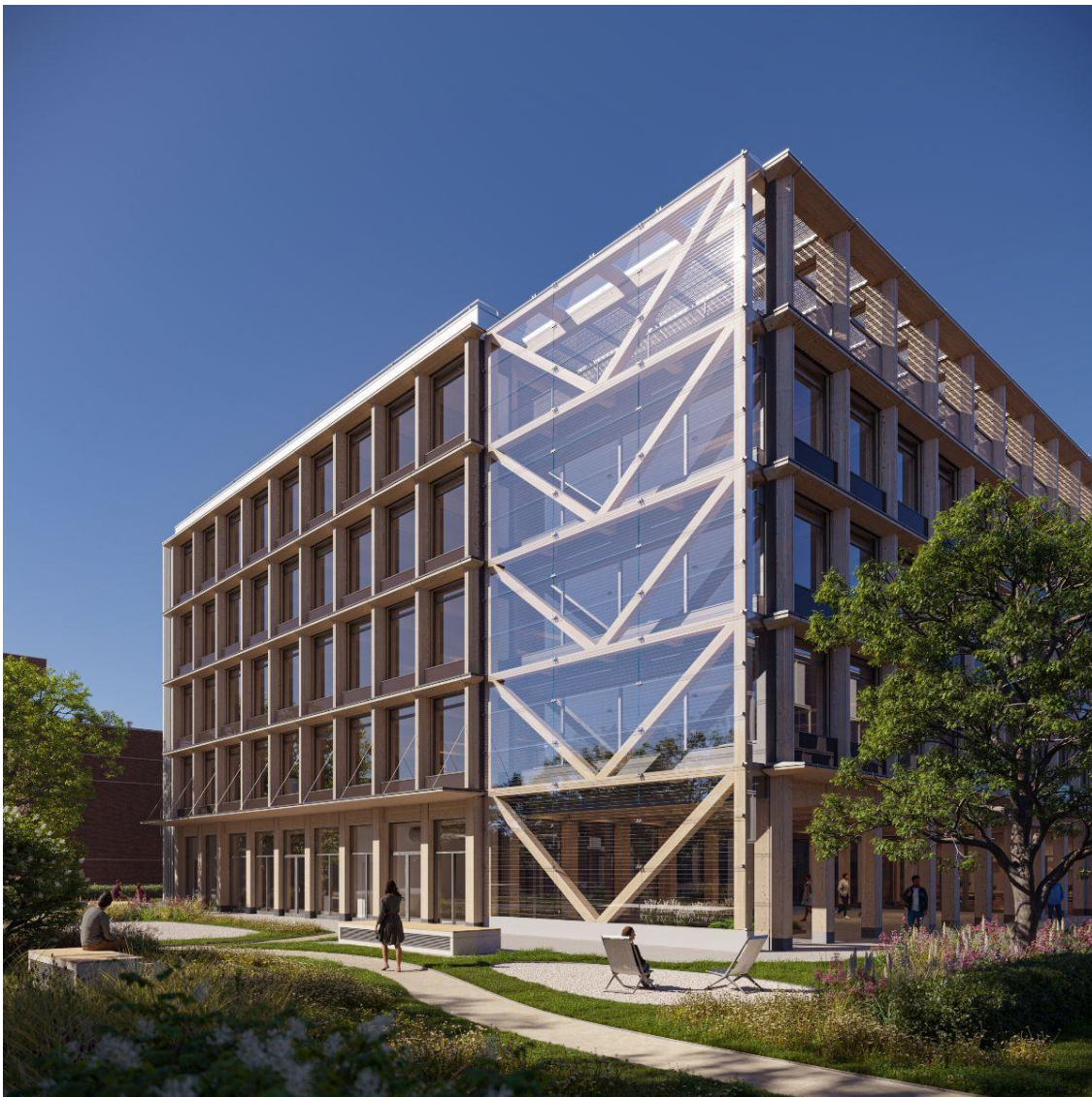
Das Büroprojekt ZERO in Stuttgart wird fast komplett in Holz errichtet. Bild: CPM GmbH
