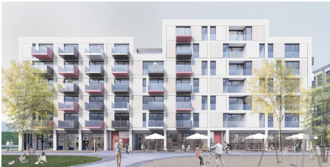
Bestandssanierung nach Plan: CollignonArchitektur geht Projekte dabei ganzheitlich an.
