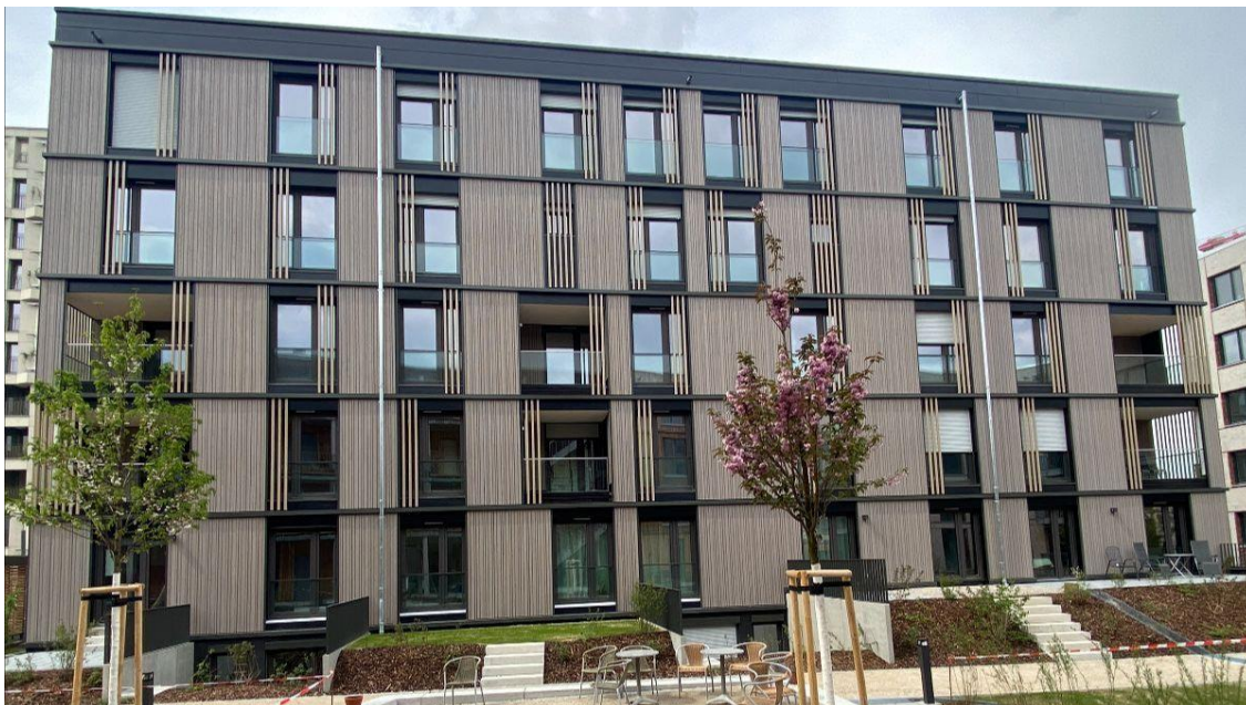
Das Projekt konnte pünktlich zur BUGA 2023 fertiggestellt werden. Bild: IMMPRINZIP
