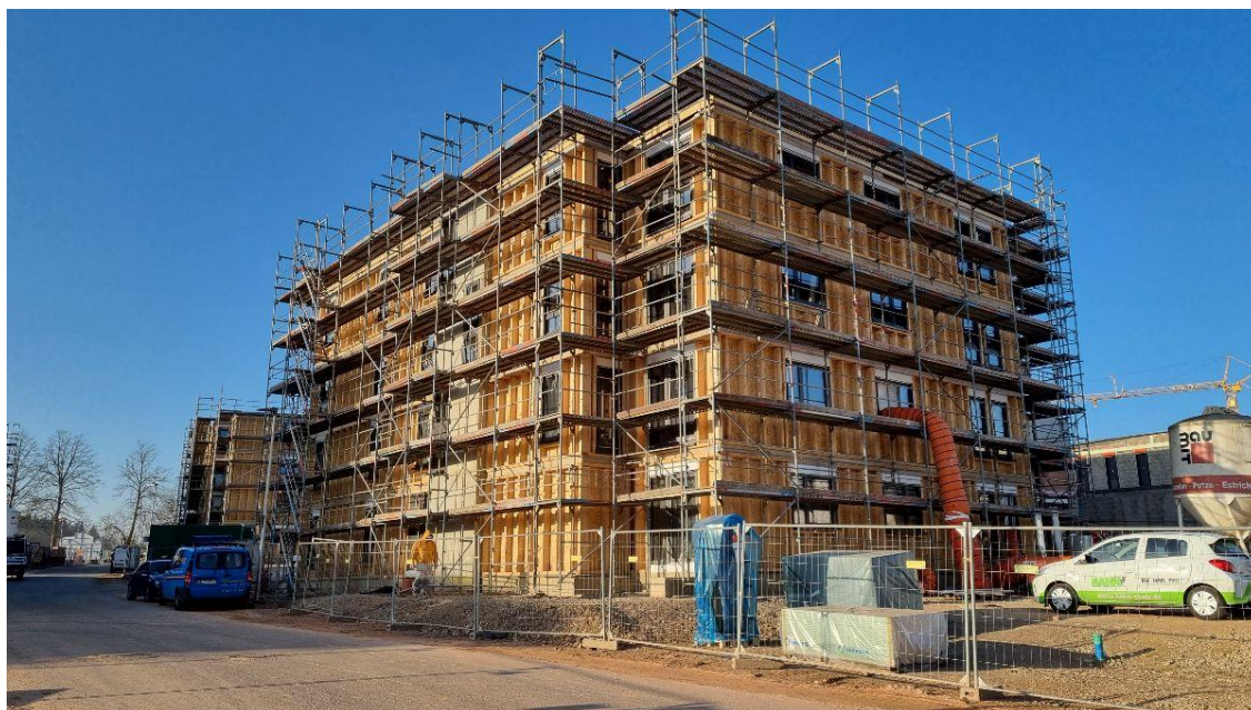
Holzhybridbau auf Castelnau-Mattheis Quellenangabe: IMMPRINZIP GmbH & Co. KG
