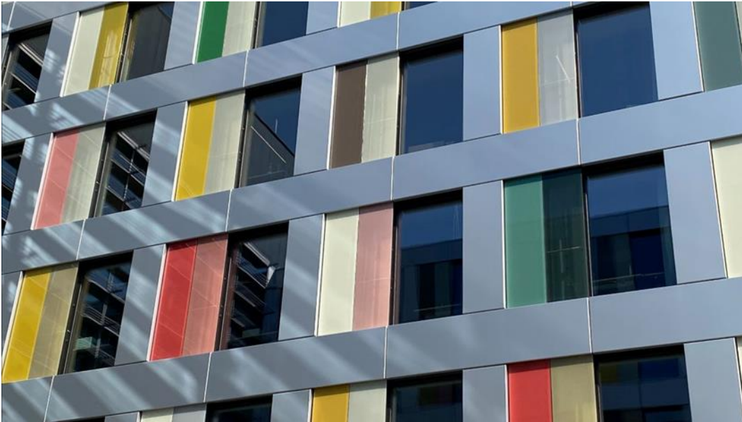
Die Fassade des LUISEBLOCK WEST im Berliner Regierungsviertel
