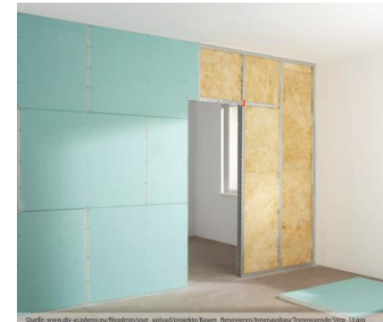
herkömmliche Bauweise: Gipskarton
