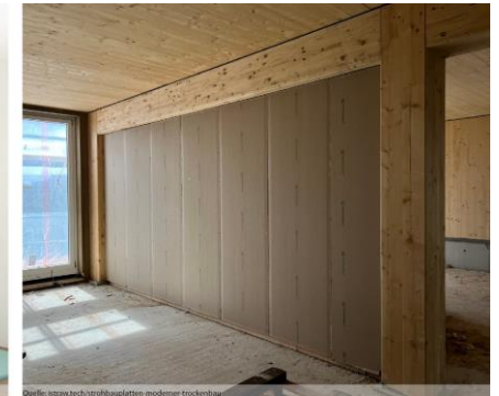
zirkuläre Bauweise: Strohbau
